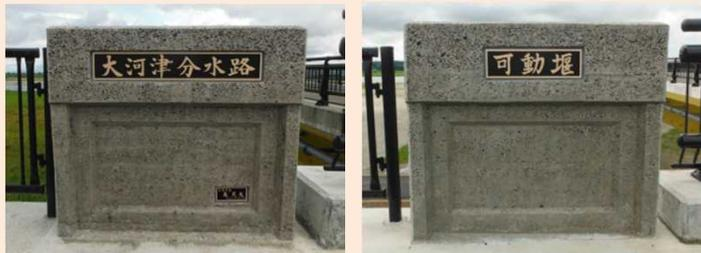
新たな可動堰管理橋の橋詰めに設置された親柱。撤去した旧可動堰の管理橋高欄のコンクリートを用いて作られています。
