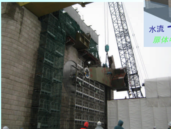
200t吊クレーンでの据付作業の状況
