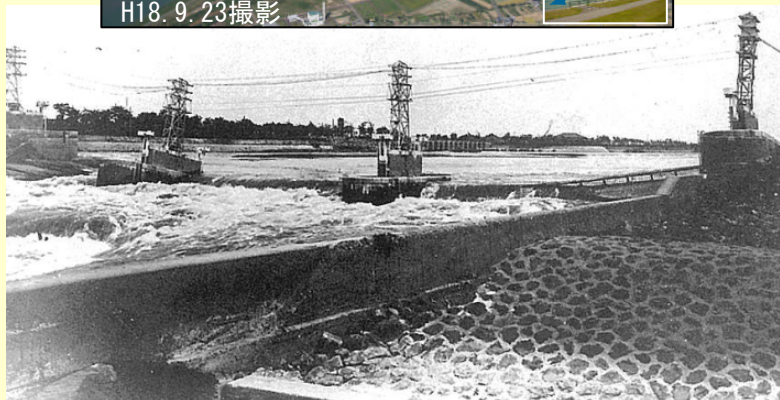
陥没した自在堰（昭和2年）
