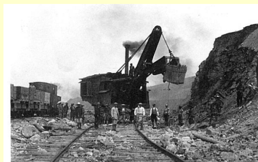
山間部掘削に使用した当時の施工機械
