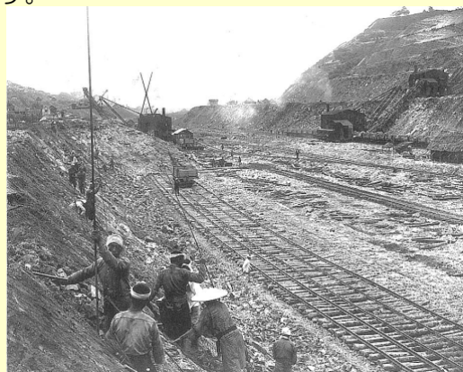
山間部の掘削工事状況（明治44年頃）
