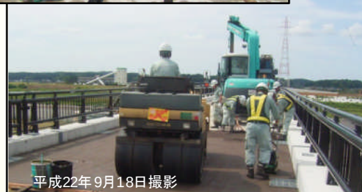
管理橋舗装 施工状況
