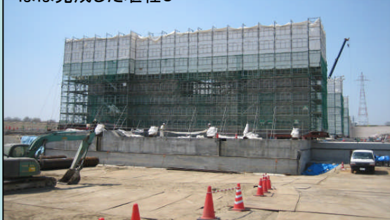
ほぼ完成した堰柱5
