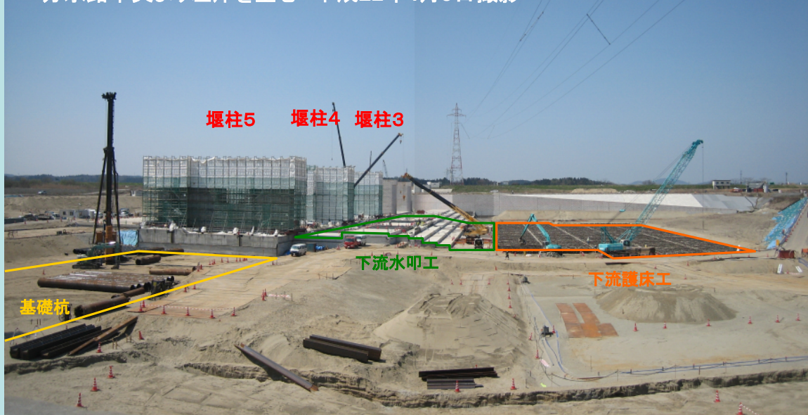
分水路中央より左岸を望む 平成21年4月9日撮影
