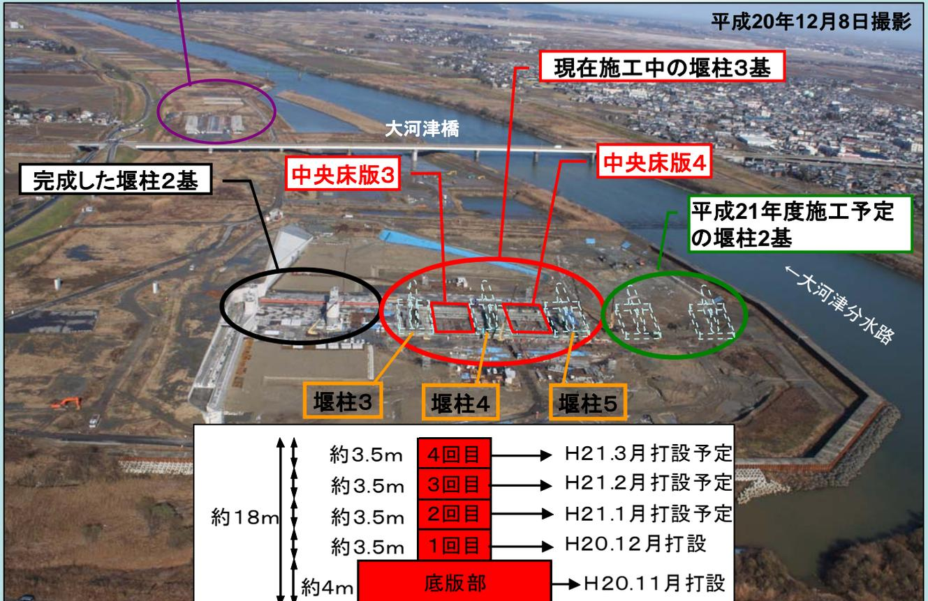
堰柱3、堰柱4、堰柱5のコンクリート打設の順序
