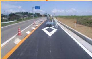
24時間体制で緊急復旧工事を実施し、10日間で堤防機能と道路機能を回復しました。写真は完成目前の区画線を設置しているところです。
