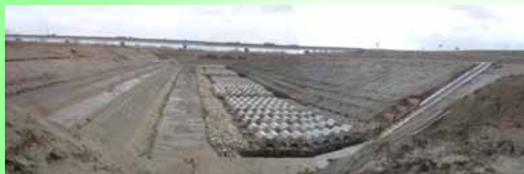
昨年度の護岸工事の完成状況
