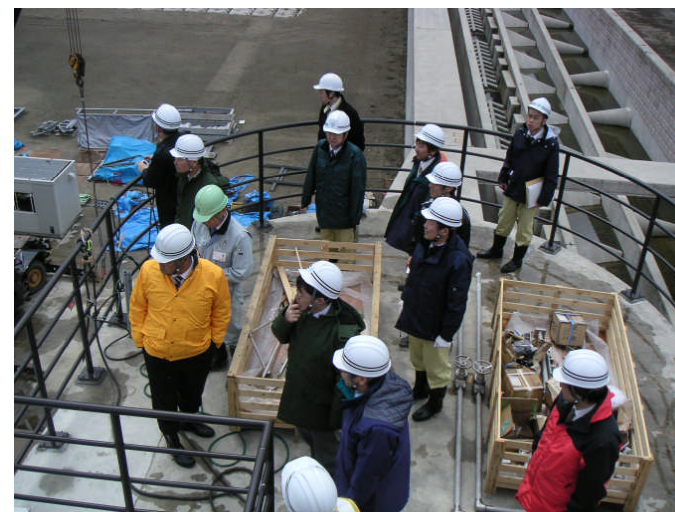
可動堰本体工事現場視察状況
