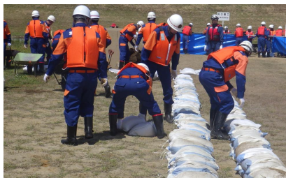
積み土のう工
