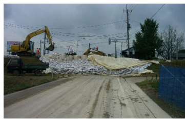
水防活動の状況（H16.7出水）
