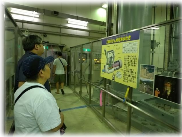
常用洪水吐ゲート室
