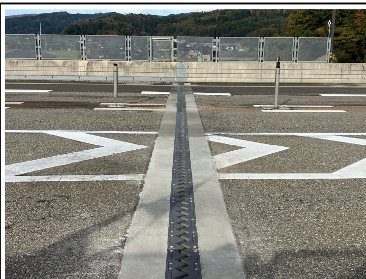
橋梁の補修状況
