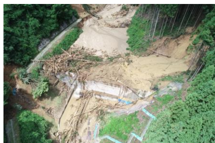
下土沢砂防堰堤（R4.8 撮影）
