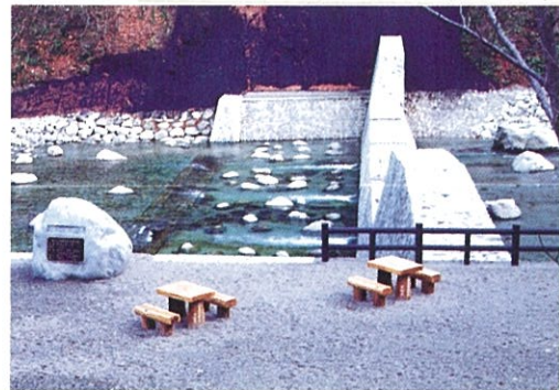
玉川上流第二号砂防ダム
