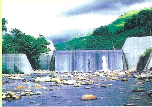
穴渕砂防ダム
