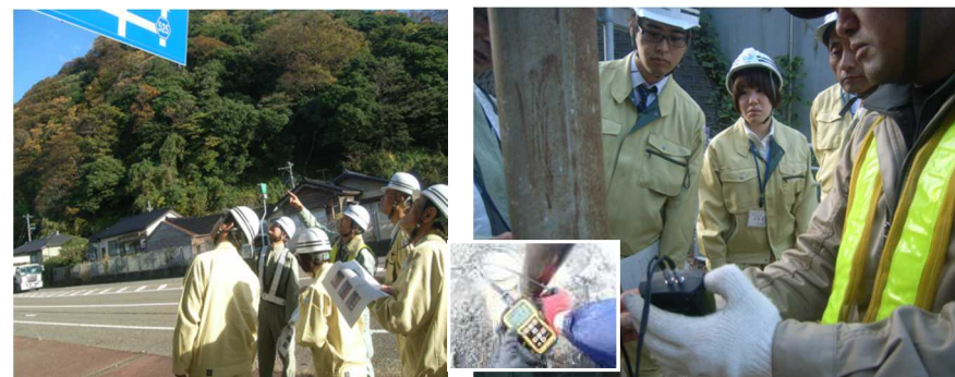
受発注者による合同現地確認状況
