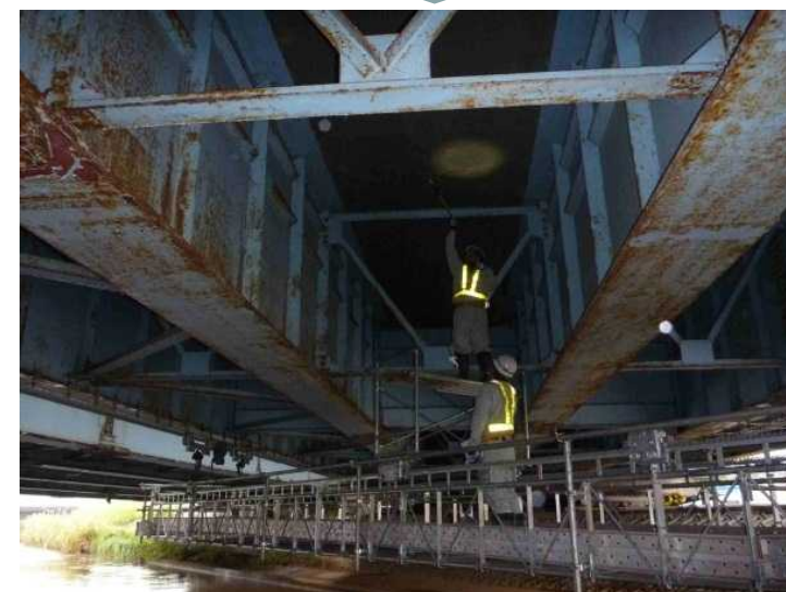
移動式足場による点検
